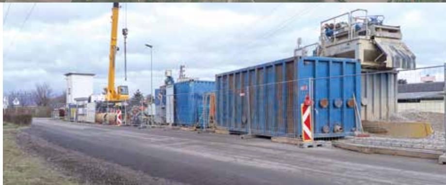
Sanierung unter Volllast nur mit einer provisorischen Umgehungsleitung und dem permanenten Einsatz (7 Tage pro Woche, 24 h pro Tag) von Hochleistungspumpen möglich wäre. Um diese weitere, mit viel Lärm verbundene, Baustelle mitten durch Kottlingbrunn zu vermeiden, wird die Sanierung erst nach Fertigstellung des neuen Hauptsammlers erfolgen, da die anfallenden Abwässer dann durch diesen umgeleitet werden können.
