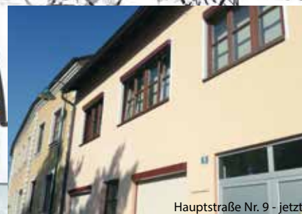
Hauptstraße Nr. 9 - jetzt
